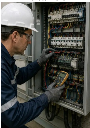
Foto №5. Ispezione del quadro elettrico eseguita
