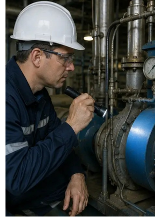
Foto №2. Ispezione delle apparecchiature meccaniche completata
