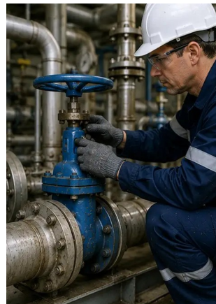
Foto №10. Stato della valvola valutato durante l'ispezione
