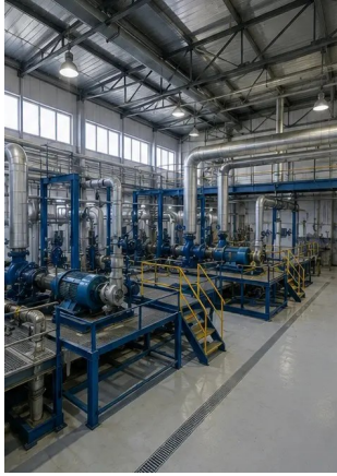
Foto №1. Panoramica generale dell'impianto industriale
