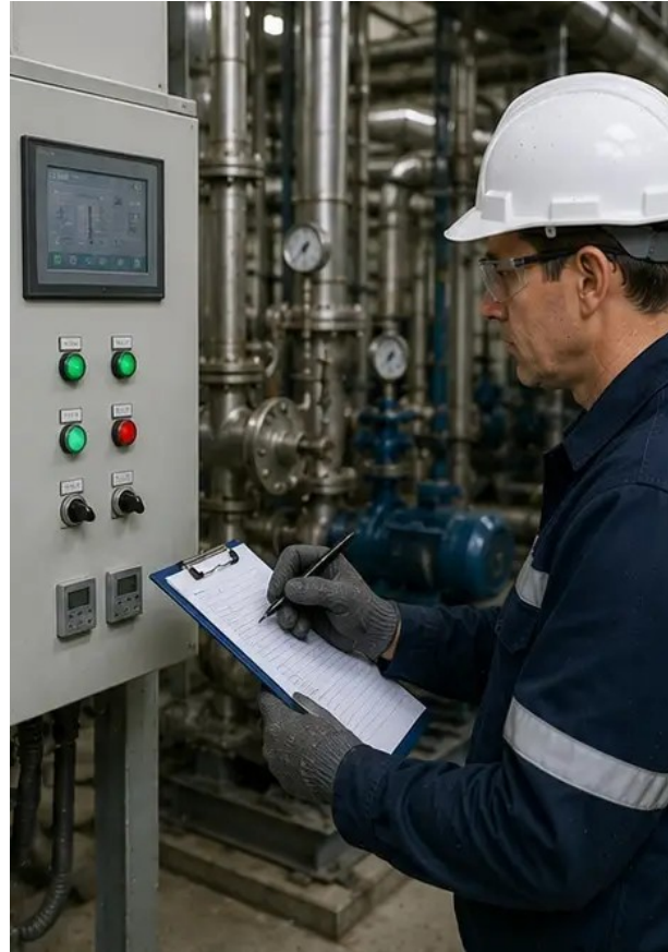
Foto №14. Verifica finale della manutenzione eseguita
