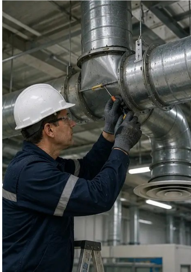
Foto №8. Manutenzione del sistema di ventilazione completata
