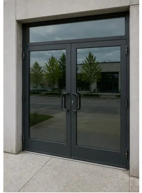
Photo #7. Stato delle porte ispezionato e registrato
