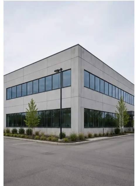
Photo #1. Vista generale della proprietà ispezionata
