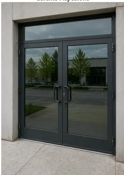
Photo #7. Stato delle porte ispezionato e registrato
