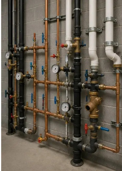
Photo #10. Ispezione dell'impianto idraulico completata
