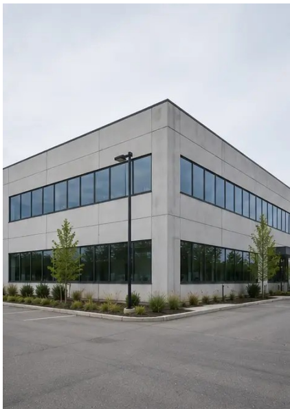
Photo #1. Vista generale della proprietà ispezionata
