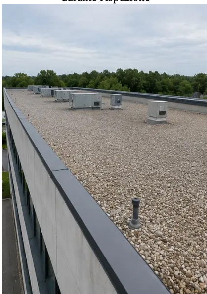
Photo #5. Ispezione dello stato del tetto completata
