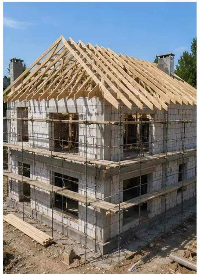
Foto №8 Lavori di installazione del tetto completati
