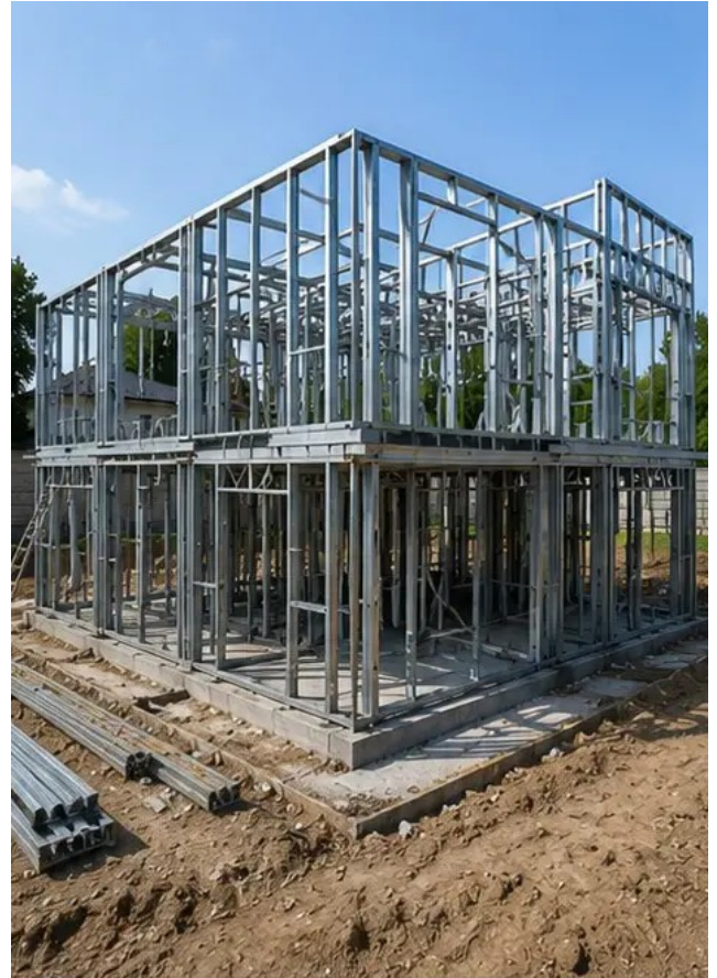
Foto №6 Montaggio della struttura portante in corso
