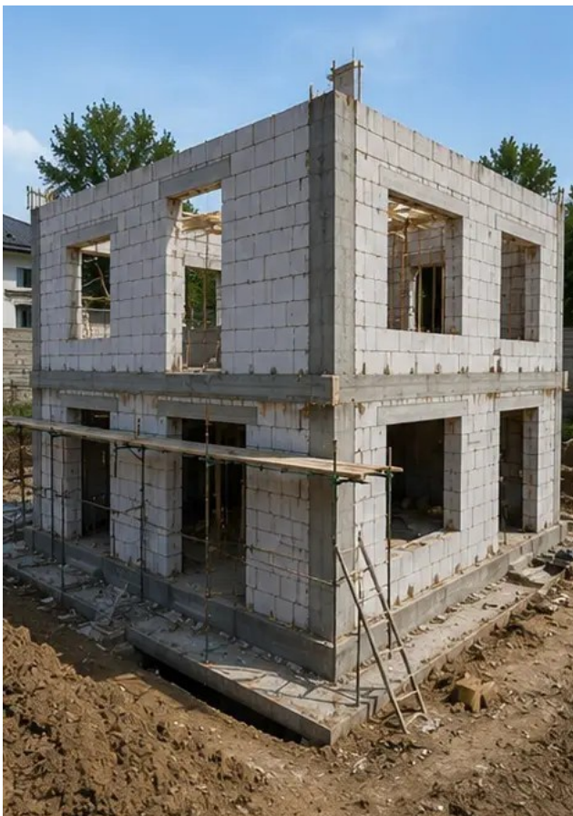
Foto №7 Costruzione dei muri esterni completata per la sezione dell'edificio
