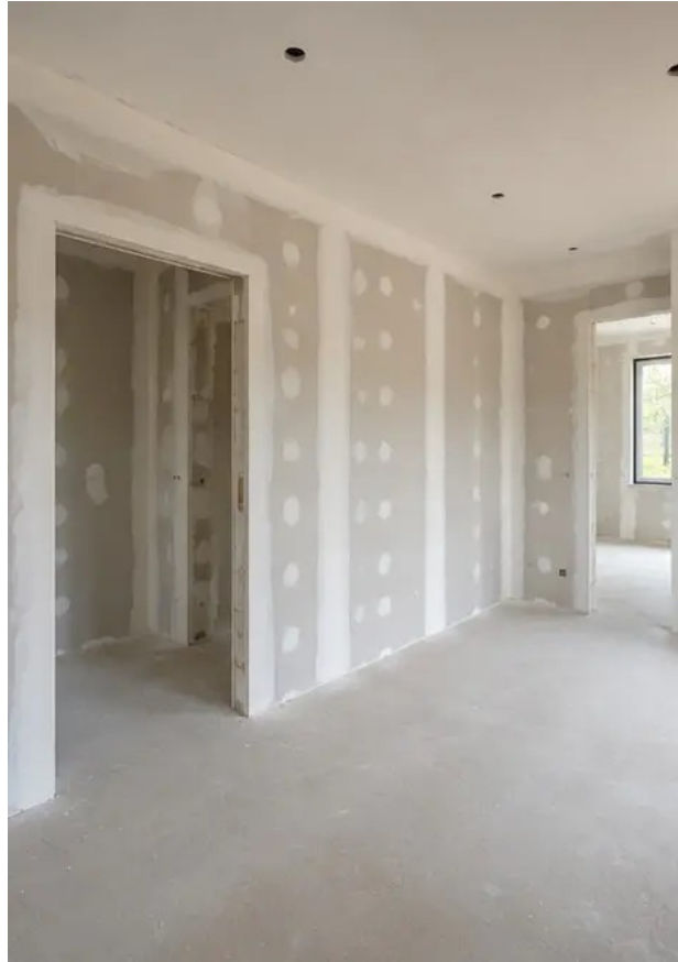
Foto №11 Lavori di finitura delle pareti interne in corso
