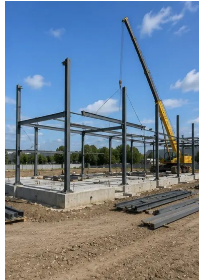
Foto №6. Montaggio della struttura portante iniziato
