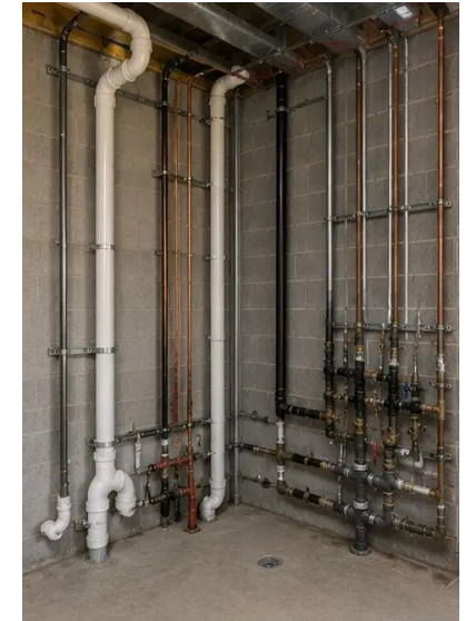
Foto №12. Installazione degli impianti idraulici completata
