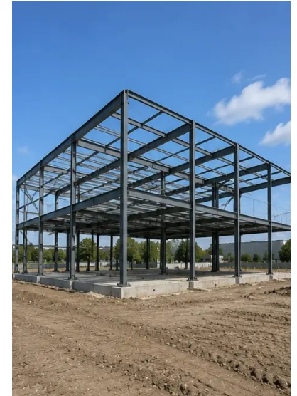
Foto №8. Struttura portante completata secondo il programma del progetto
