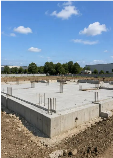
Foto №5. Costruzione delle fondazioni completata
