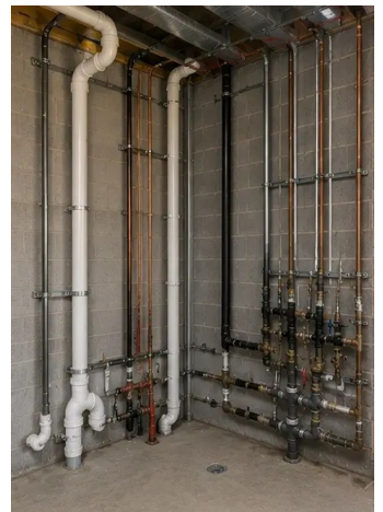
Foto №12. Installazione degli impianti idraulici completata
