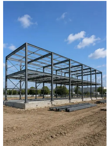
Foto №7. Costruzione della struttura portante in corso
