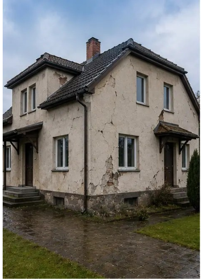
Foto №1 Vista generale della proprietà ispezionata
