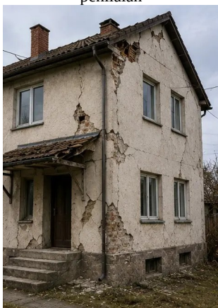
Photo #15. Gambaran beberapa lokasi kerusakan
