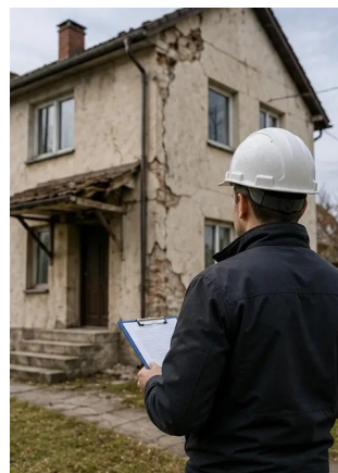
Photo #16. Foto ringkasan inspeksi kerusakan akhir
