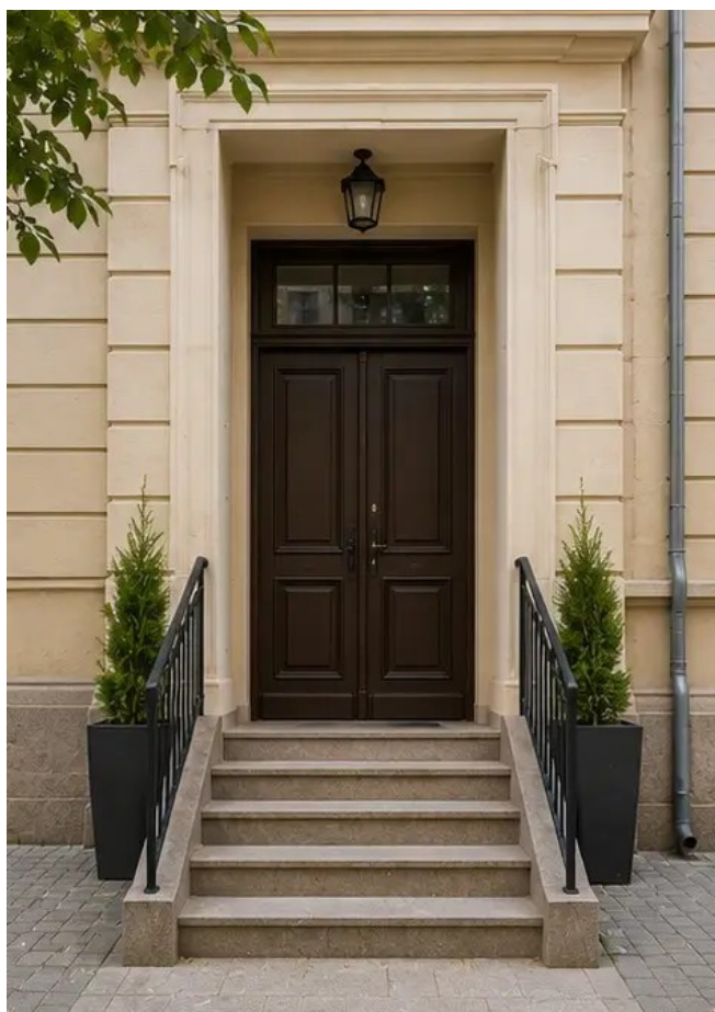
Foto №16 Pintu masuk properti setelah perbaikan
