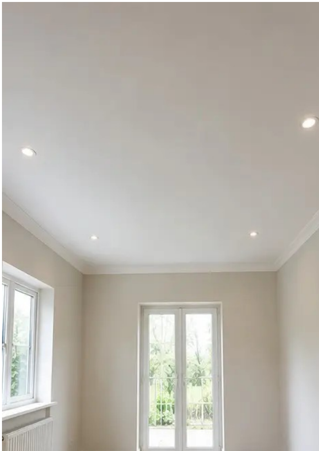
Foto №8 Kondisi langit-langit setelah renovasi
