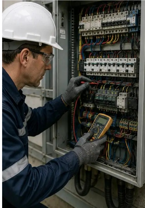
Foto №5. Inspeksi kabinet listrik dilakukan
