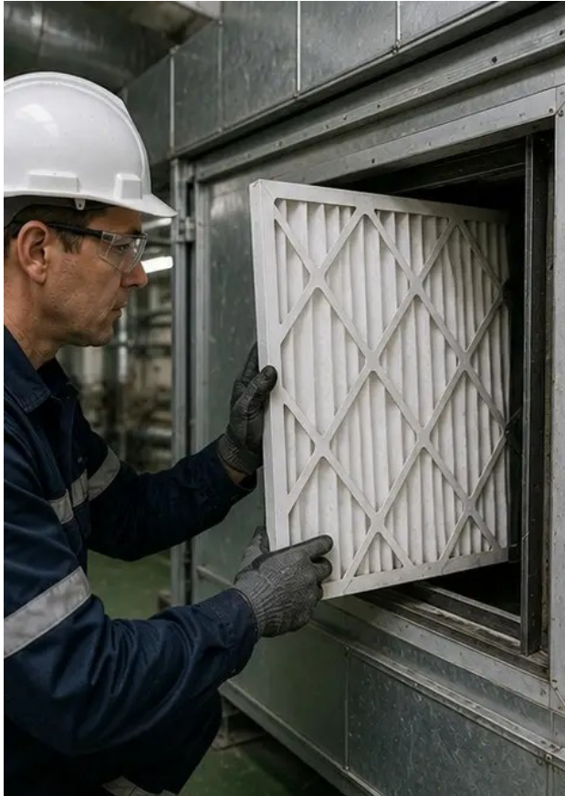
Foto №7. Penggantian filter udara selesai
