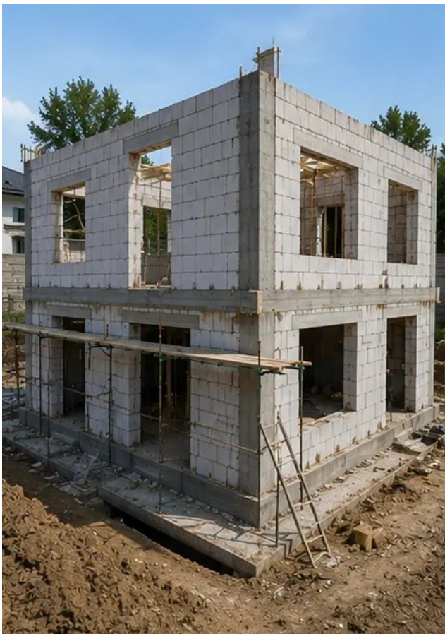
Foto №7 Konstruksi dinding luar selesai untuk bagian bangunan
