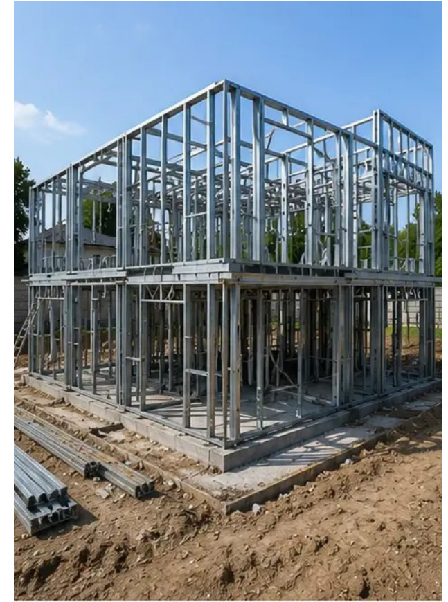
Foto №6 Perakitan rangka struktural sedang berlangsung
