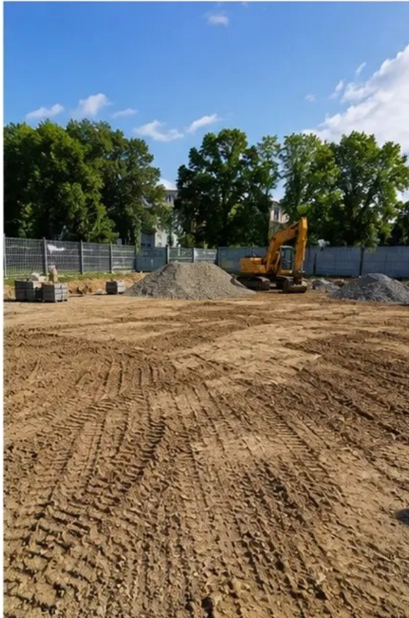
Foto №1 Pekerjaan persiapan lokasi selesai sebelum dimulainya konstruksi
