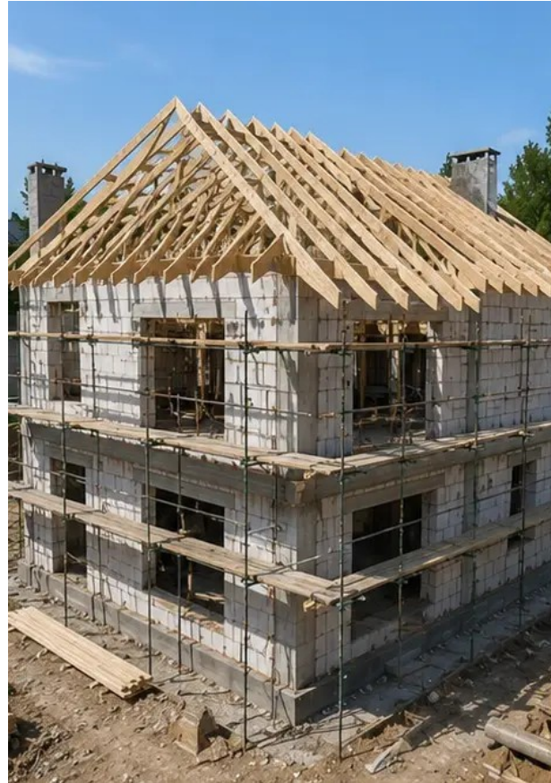
Foto №8 Pekerjaan pemasangan atap selesai
