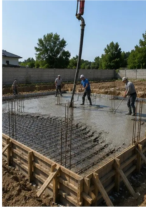
Foto №5 Operasi pengecoran beton dilakukan pada elemen pondasi
