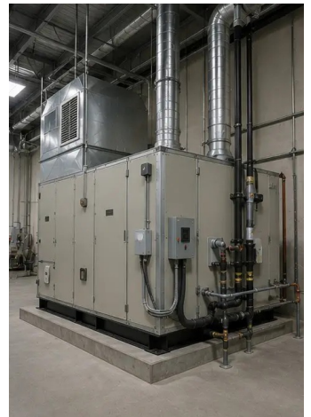
Foto №14. Pemasangan peralatan selesai
