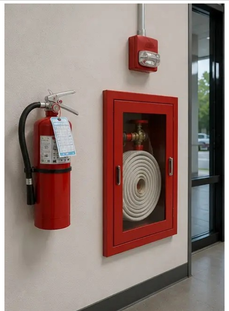
Photo #12. Peralatan keselamatan diperiksa dan dicatat
