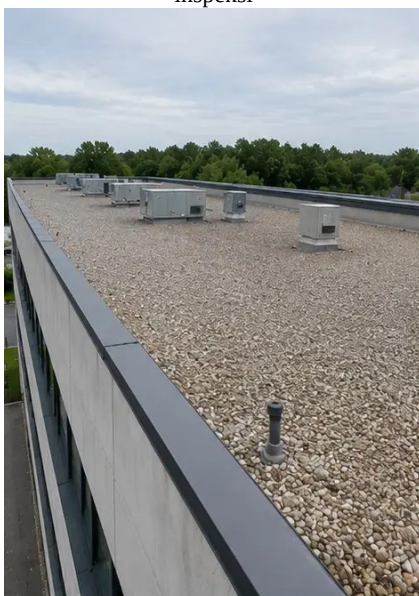
Photo #5. Inspeksi kondisi atap selesai
