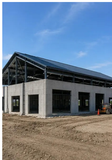
Fotó №10. Tetőépítés befejezve
