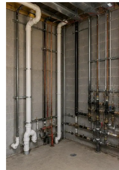
Fotó №12. Vízvezeték-rendszerek szerelése befejezve
