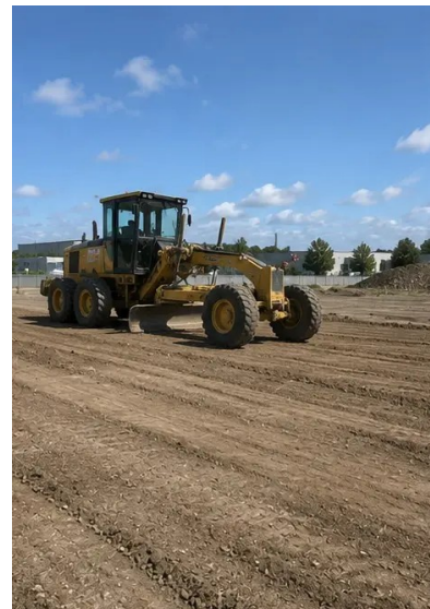
Fotó №3. Terep megtisztítása és egyengetése befejezve
