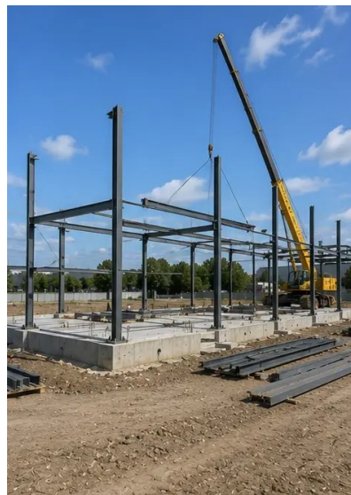
Fotó №6. Teherhordó váz szerelése megkezdve
