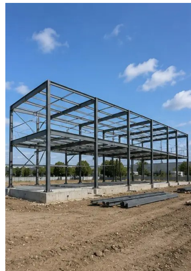
Fotó №7. Teherhordó váz építése folyamatban
