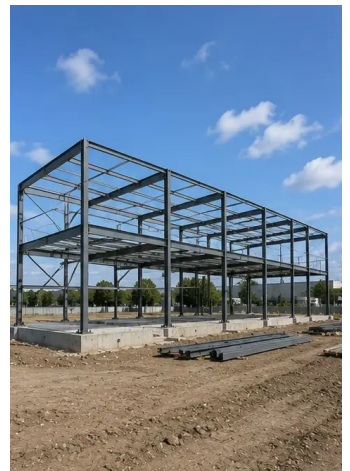
Fotó №7. Teherhordó váz építése folyamatban
