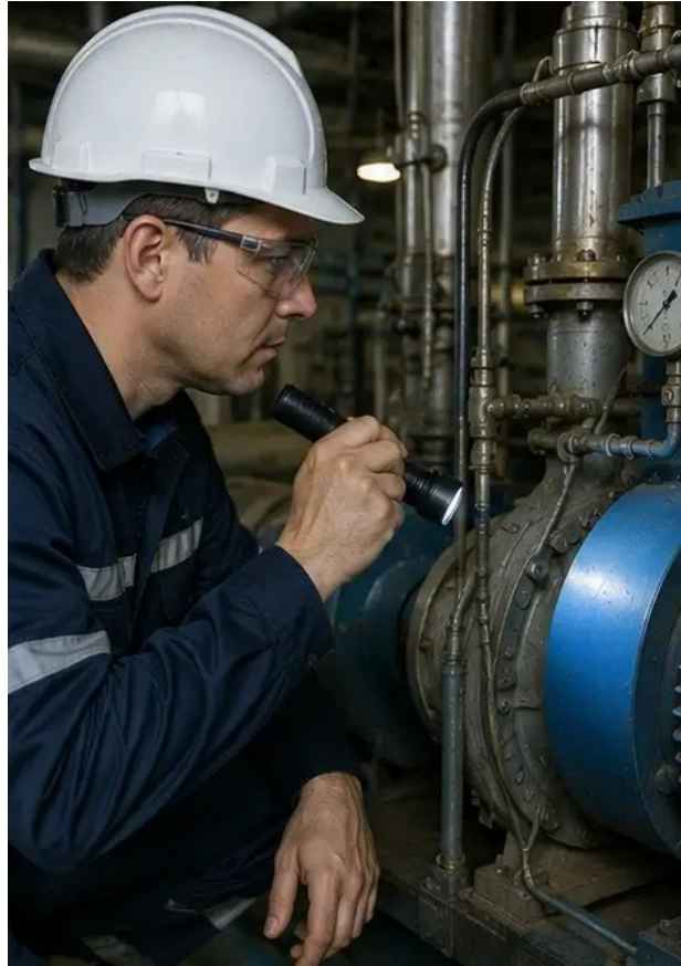
Fotó №2. Gépészeti berendezések ellenőrzése befejezve
