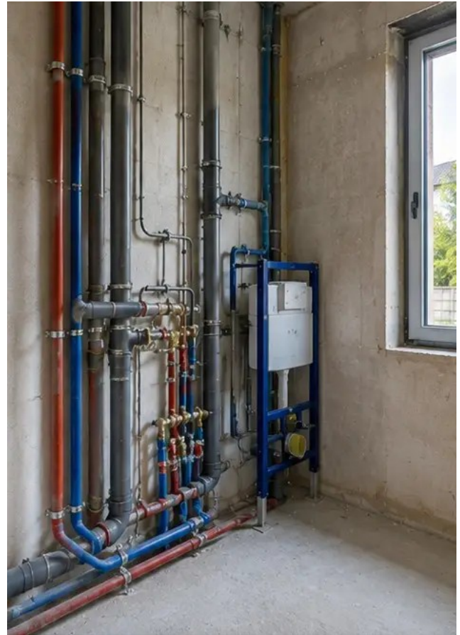
Fotó №10 Vízvezeték-rendszerek szerelése befejezve a kijelölt területeken
