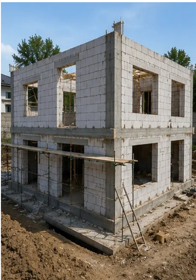
Fotó №7 Külső falak építése befejezve az épületszakaszra
