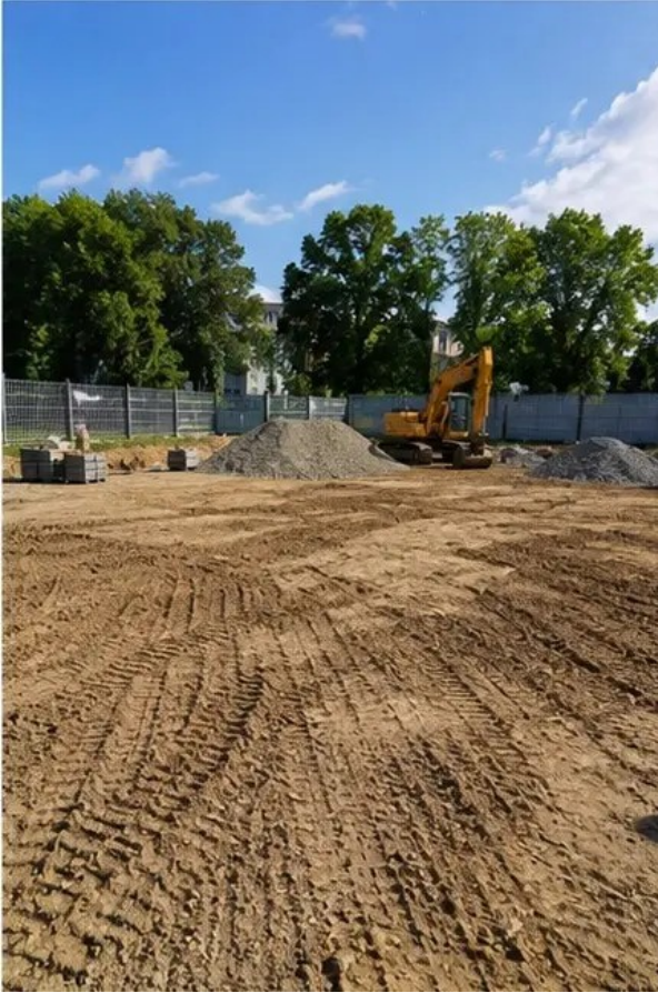
Fotó №1 A munkaterület előkészítése befejezve az építkezés megkezdése előtt
