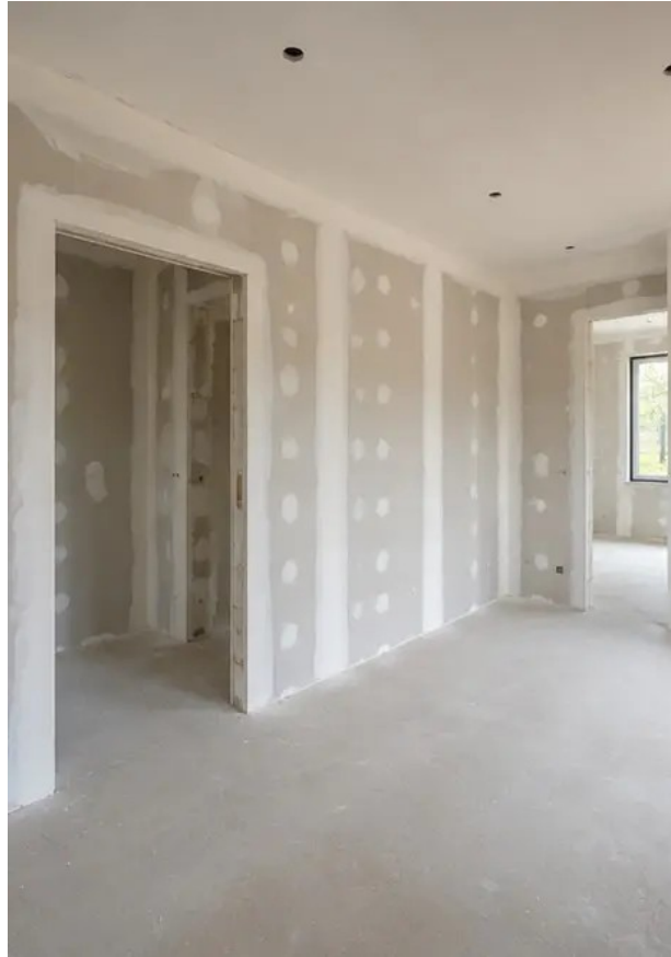
Fotó №11 Belső falak befejező munkái folyamatban
