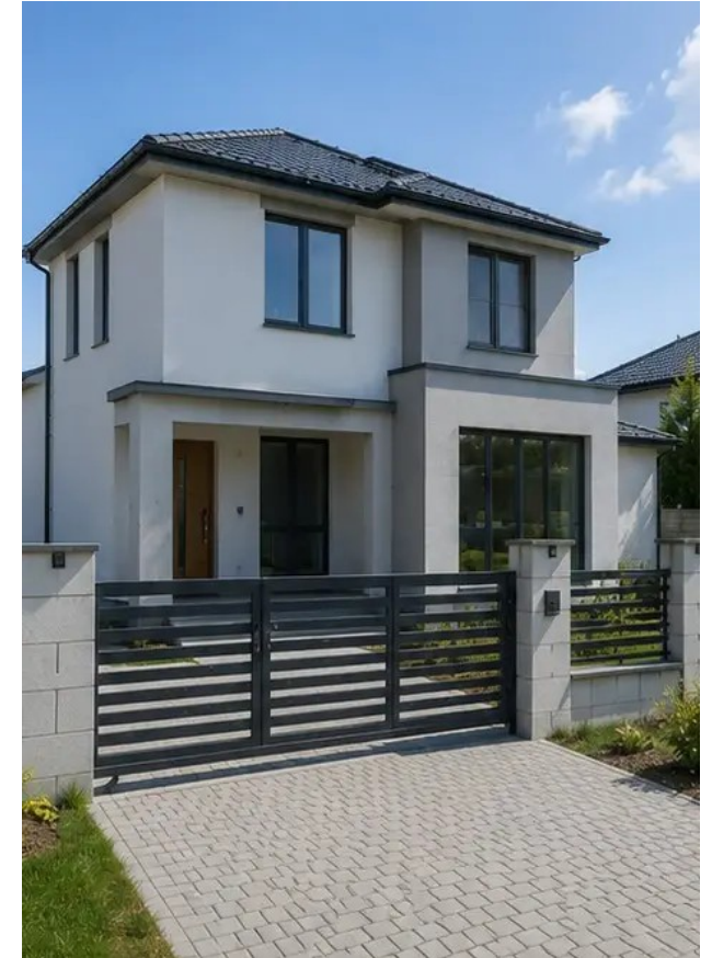
Fotó №15 Az elkészült épület külső megjelenése építés után
