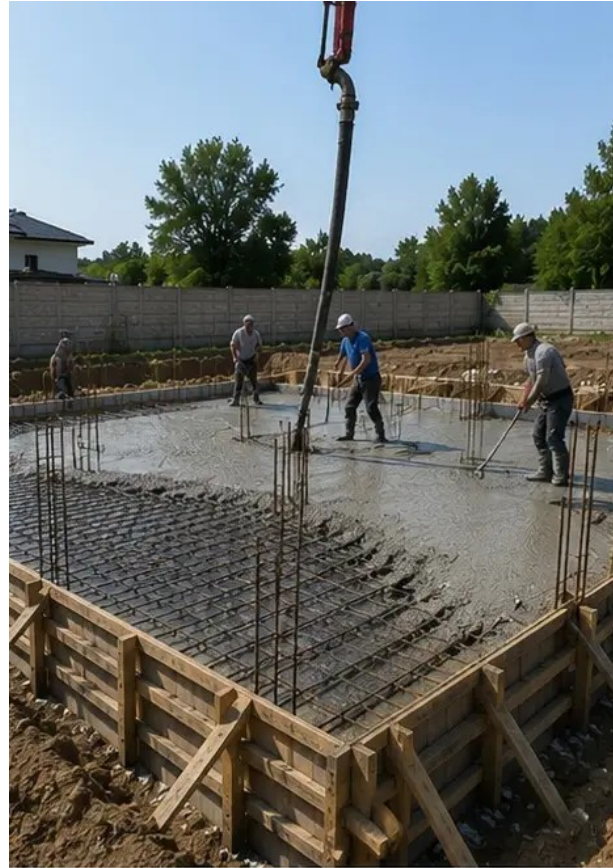
Fotó №5 Betonzási munkák elvégezve az alapelemeken
