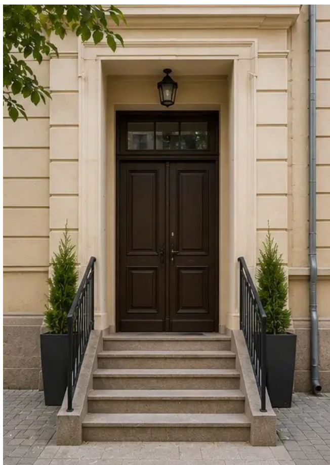
Fotó №16 Az ingatlan bejárata javítás után
