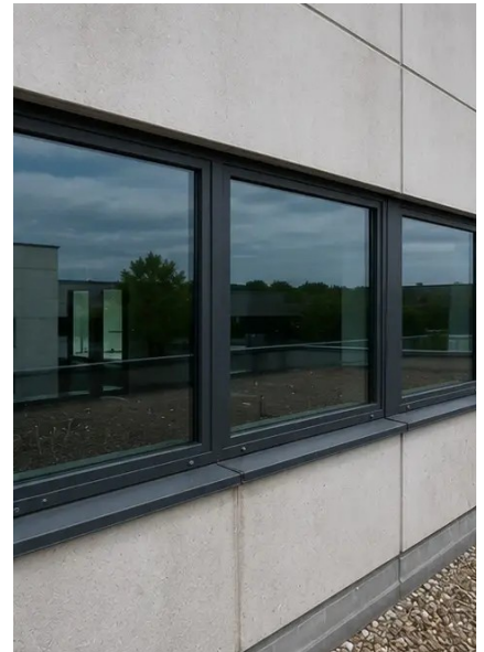
Photo #6. Nyílászárók állapota dokumentálva az ellenőrzés során
