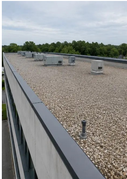
Photo #5. Tető állapottfelmérése befejezve
