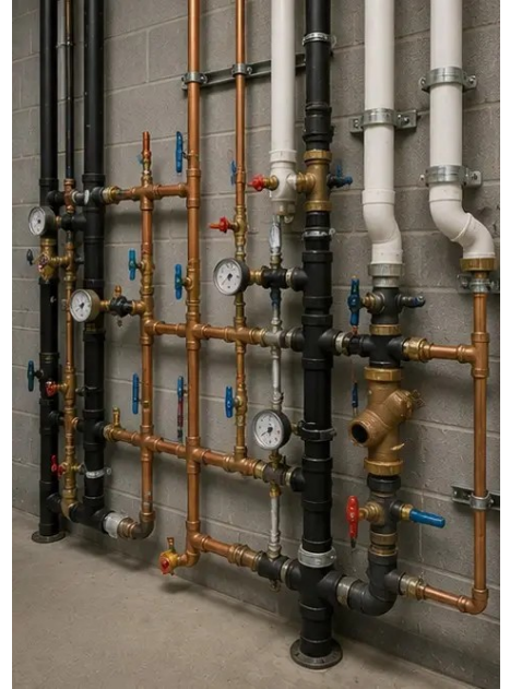
Photo #10. Vízvezeték-rendszer ellenőrzése befejezve
