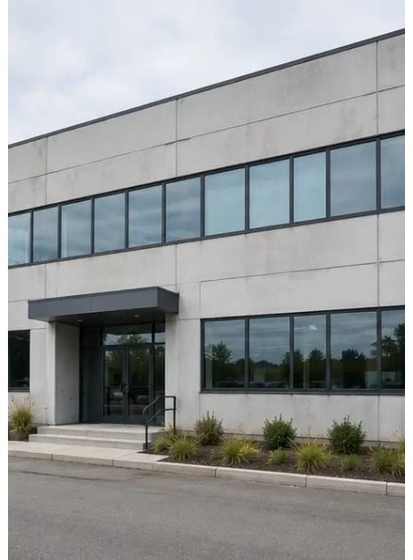
Photo #2. Stanje prednje fasade tijekom inspekcije
