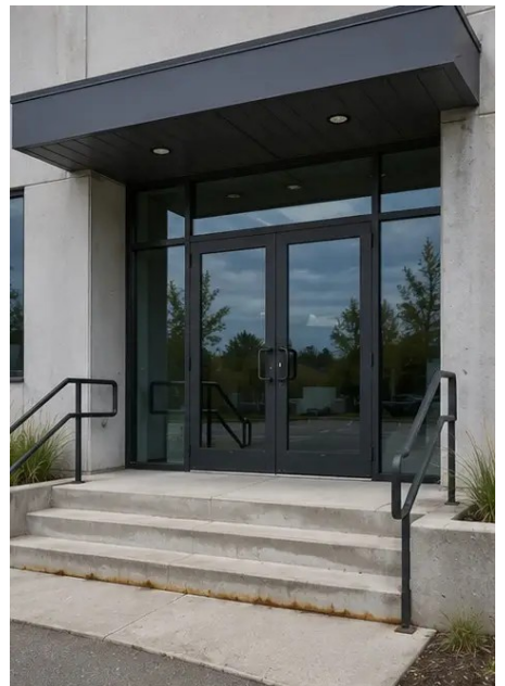
Photo #3. Pregledan i dokumentiran glavni ulazni prostor
