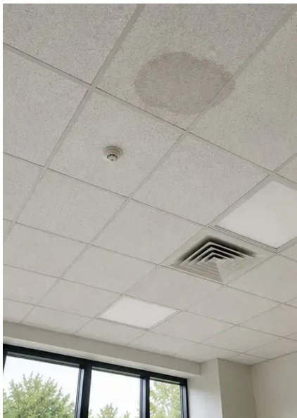
Photo #13. Stanje stropa dokumentirano tijekom inspekcije
