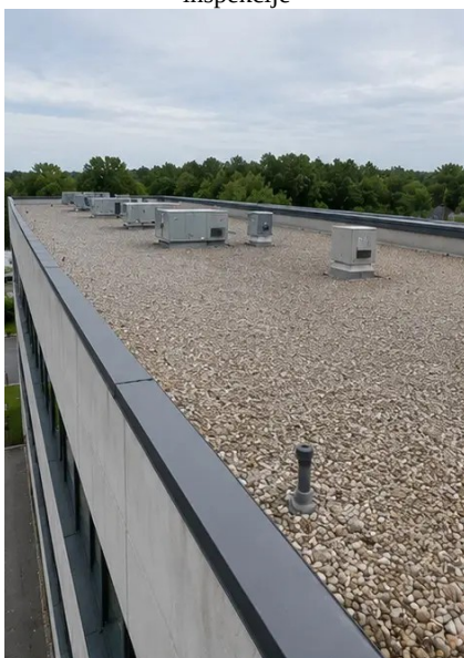
Photo #5. Pregled stanja krova dovršen
