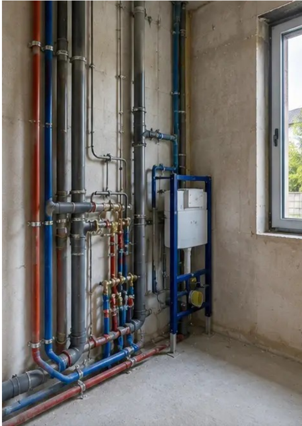
Fotografija br.10 Instalacija vodoinstalaterskih sustava završena u određenim područjima
