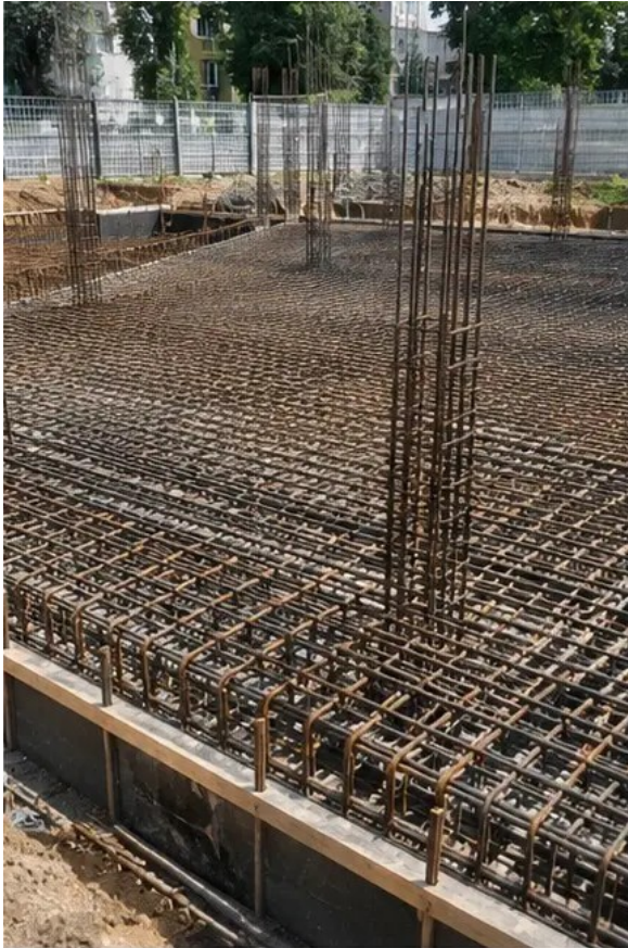
Fotografija br.4 Postavljanje armature završeno prije betoniranja
