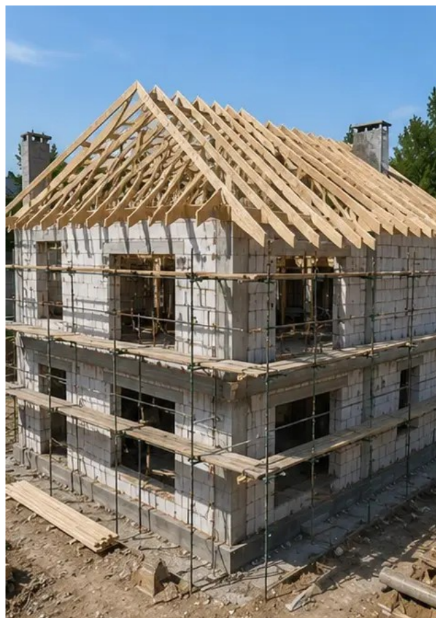
Fotografija br.8 Radovi na postavljanju krova završeni
