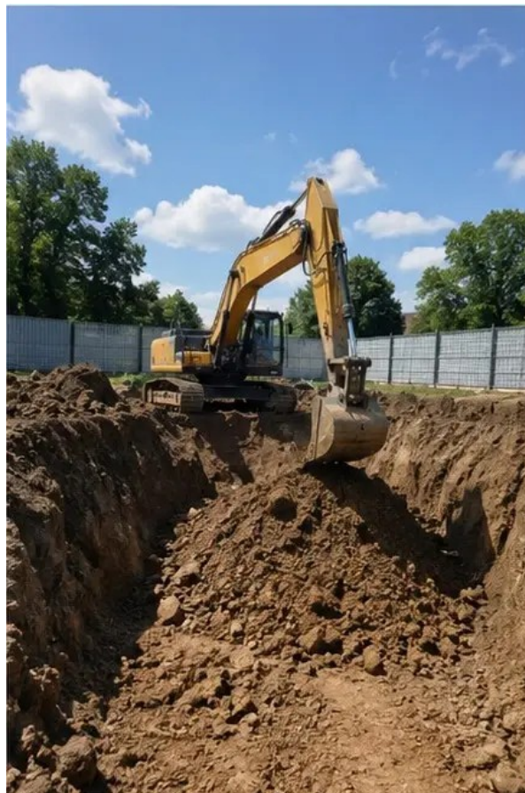
Fotografija br.2 Iskopi izvedeni prema zahtjevima projekta
