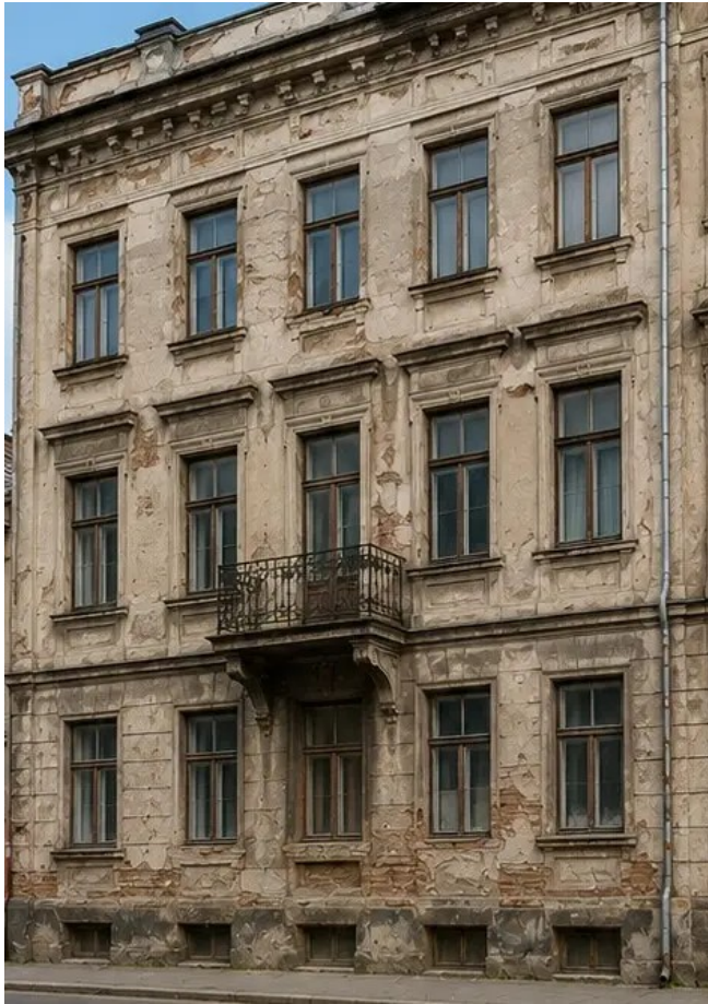
Fotografija br.13 Fasada zgrade prije restauratorskih radova
