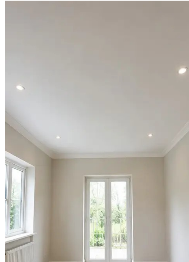
Fotografija br.8 Stanje stropa nakon renovacije
