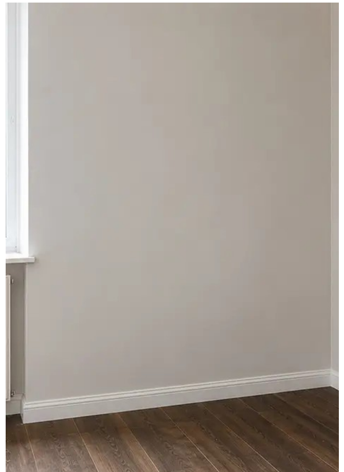
Fotografija br.4 Stanje zida nakon popravaka
