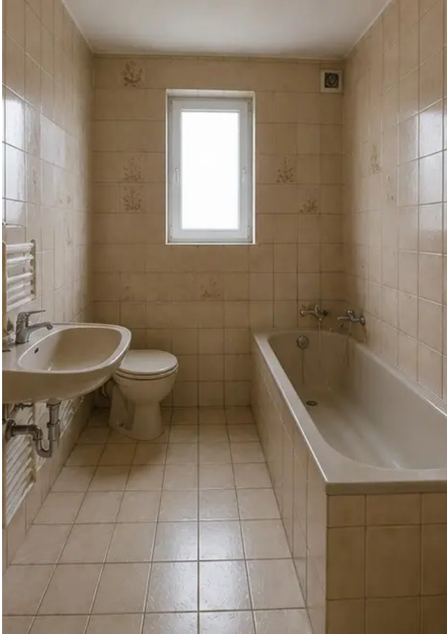
Fotografija br.9 Stanje kupaonice prije renovacije
