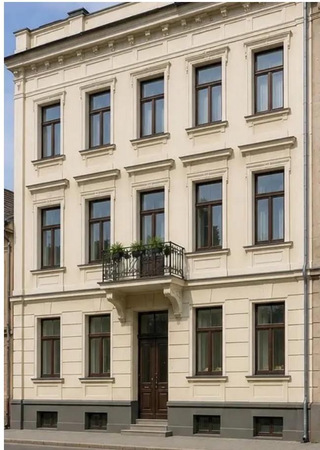
Fotografija br.14 Fasada zgrade nakon restauratorskih radova
