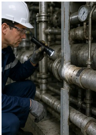
Fotografija br.9. Pregled cijevi dovršen prema planu održavanja
