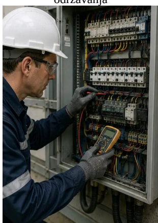
Fotografija br.5. Obavljen pregled električnog ormara
