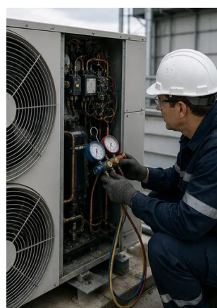
Fotografija br.6. Stanje HVAC opreme dokumentirano
