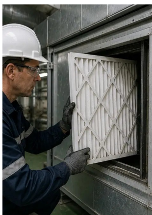
Fotografija br.7. Zamjena zračnog filtra dovršena
