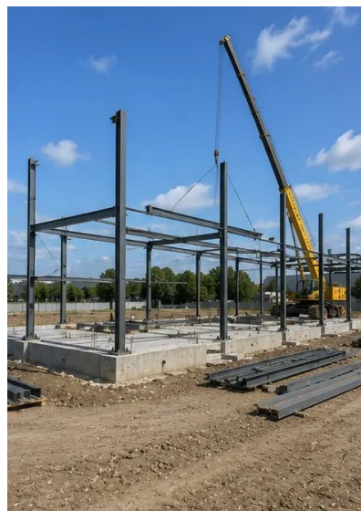
Fotografija br.6. Montaža nosive konstrukcije započeta
