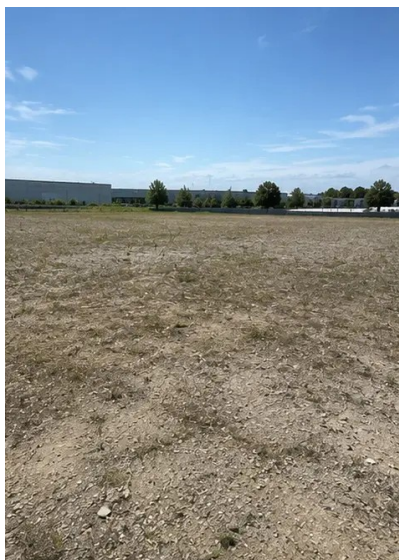
Fotografija br.1. Gradilište prije početka radova
