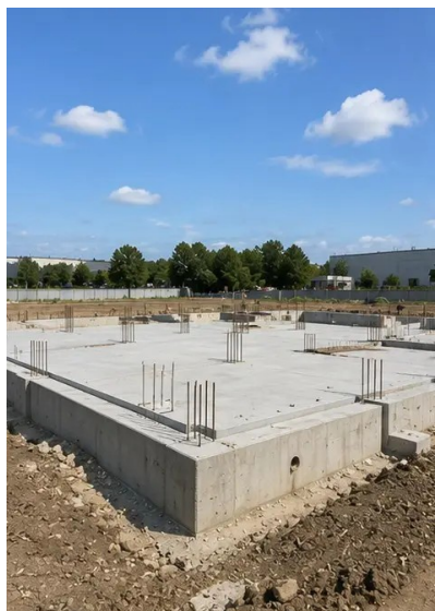
Fotografija br.5. Izgradnja temelja dovršena
