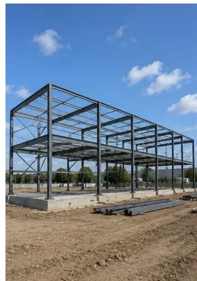
Fotografija br.7. Izgradnja nosive konstrukcije u tijeku
