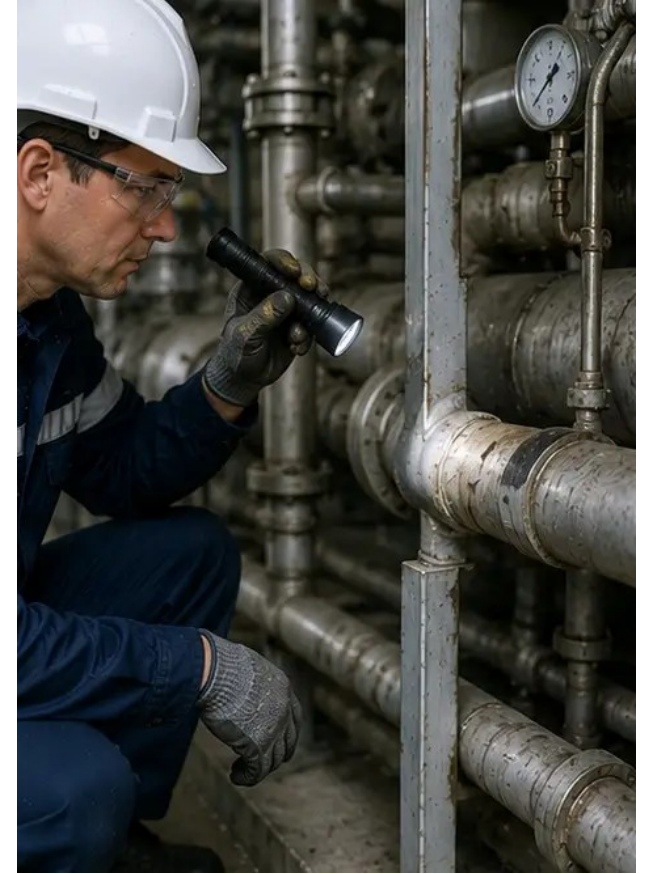
फोटो №9. रखरखाव अनुसूची के अनुसार पाइप निरीक्षण पूर्ण
