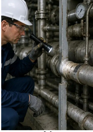
फोटो №9. रखरखाव अनुसूची के अनुसार पाइप निरीक्षण पूर्ण
