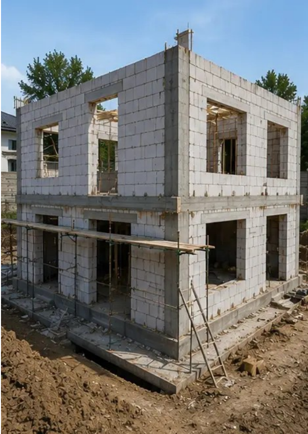
फोटो No7 भवन खंड के लिए बाहरी दीवार निर्माण पूर्ण
