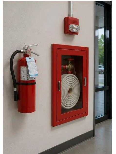
Photo #12. सुरक्षा उपकरण का निरीक्षण और रिकॉर्ड
