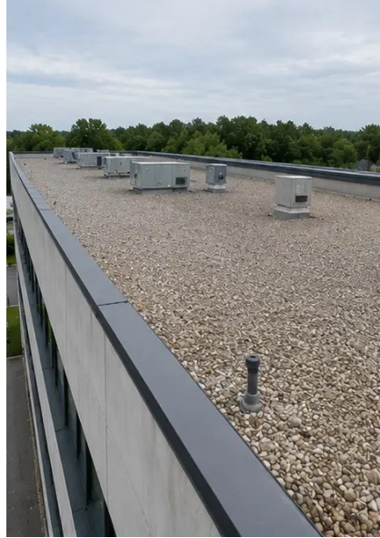
Photo #5. छत की स्थिति का निरीक्षण पूर्ण
