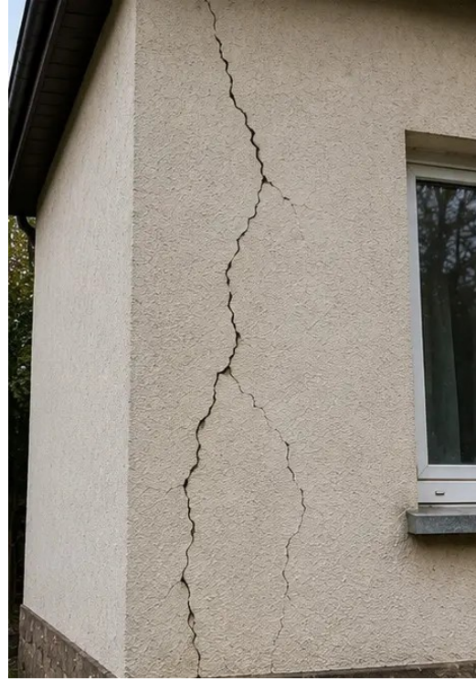
फोटो №5 निरीक्षण के दौरान दस्तावेजित संरचनात्मक दीवार दरार
