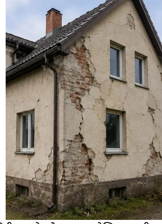
Photo #2. निरीक्षण के दौरान दस्तावेजित बाहरी क्षति का अवलोकन
