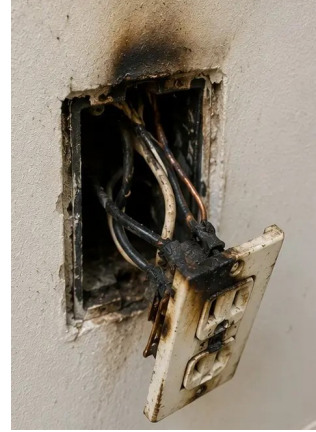
Photo #12. निरीक्षण के दौरान दर्ज विद्युत प्रणाली क्षति
