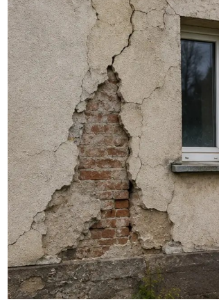
Photo #4. मूल्यांकन हेतु दस्तावेजित बाहरी दीवार क्षति
