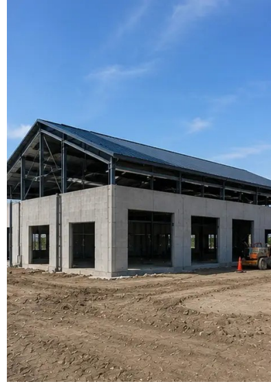
फोटो №10. छत निर्माण पूर्ण
