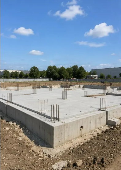
फोटो №5. नींव निर्माण पूर्ण
