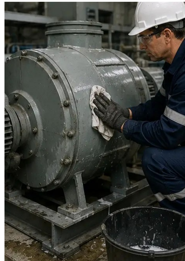
Photo n°12. Procédure de nettoyage de l'équipement terminée
