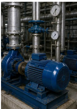
Photo n°15. Équipement fonctionnant normalement après la maintenance
