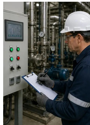
Photo n°14. Vérification finale de la maintenance effectuée
