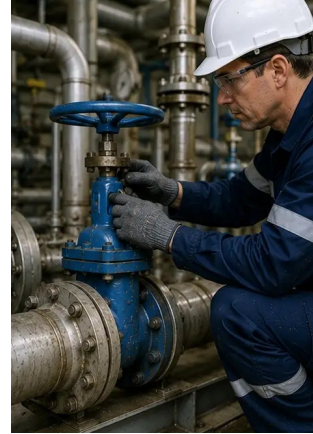
Photo n°10. État de la vanne évalué lors de l'inspection
