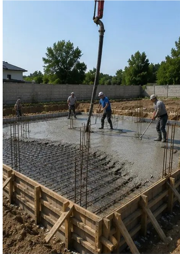
Photo n°5 Coulage du béton réalisé sur les éléments de fondation
