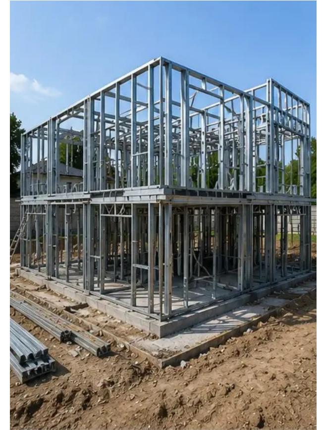
Photo n°6 Assemblage de l'ossature en cours
