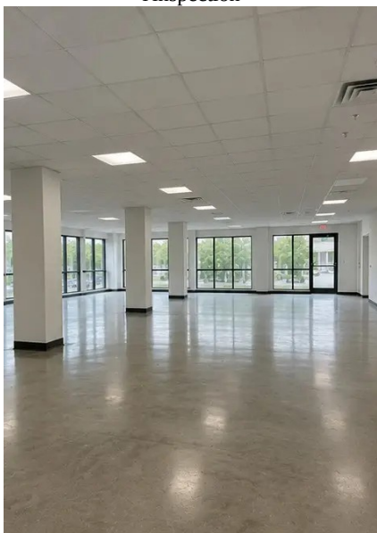
Photo #16. Aperçu final de la propriété inspectée
