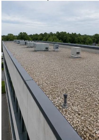
Photo #5. Inspection de l'état de la toiture terminée
