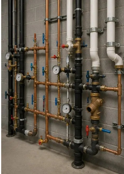
Photo #10. Inspection du système de plomberie terminée
