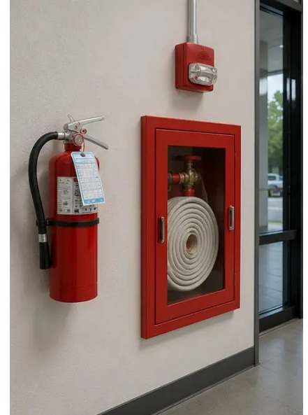
Photo #12. Équipement de sécurité inspecté et enregistré
