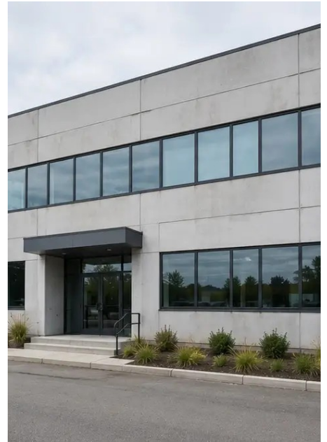
Photo #2. État de la façade avant lors de l'inspection
