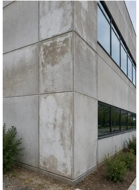
Photo #4. État des murs extérieurs enregistré lors de l'inspection
