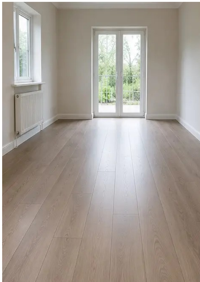
Photo n°6 État du revêtement de sol après remplacement
