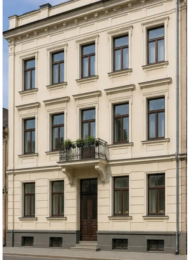
Photo n°14 Façade du bâtiment après les travaux de restauration
