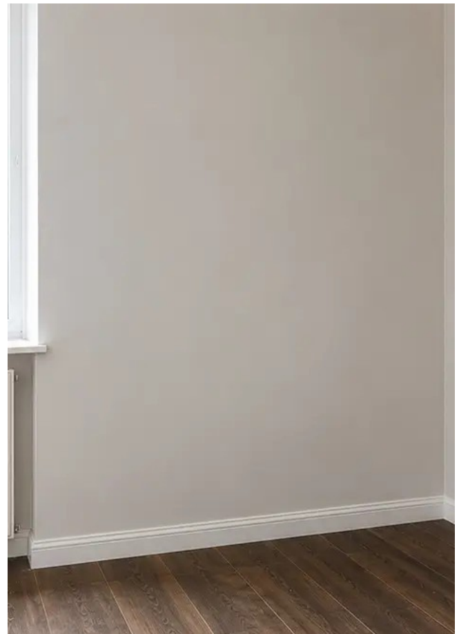
Photo n°4 État du mur après les travaux de réparation
