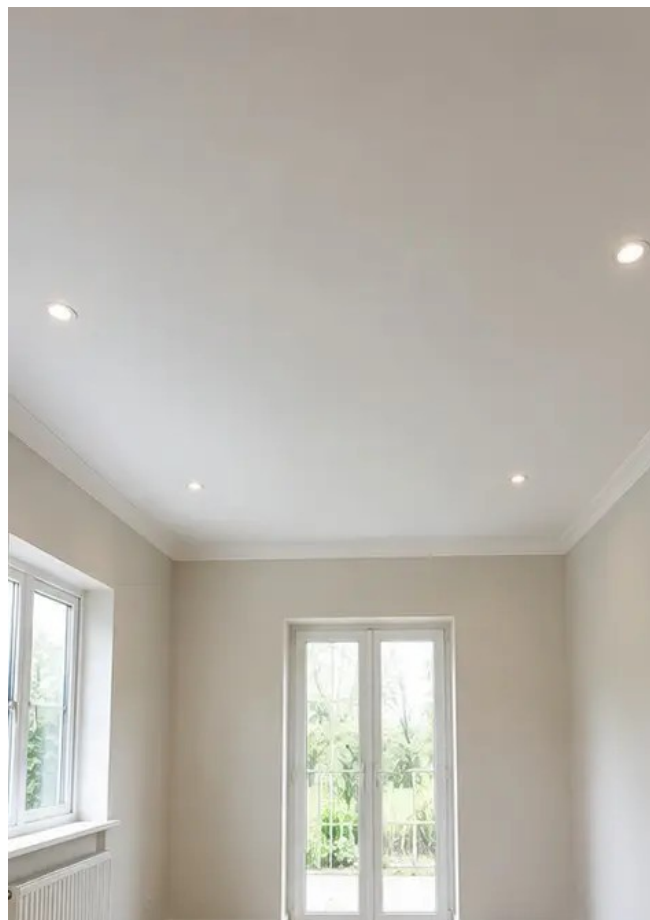
Photo n°8 État du plafond après rénovation
