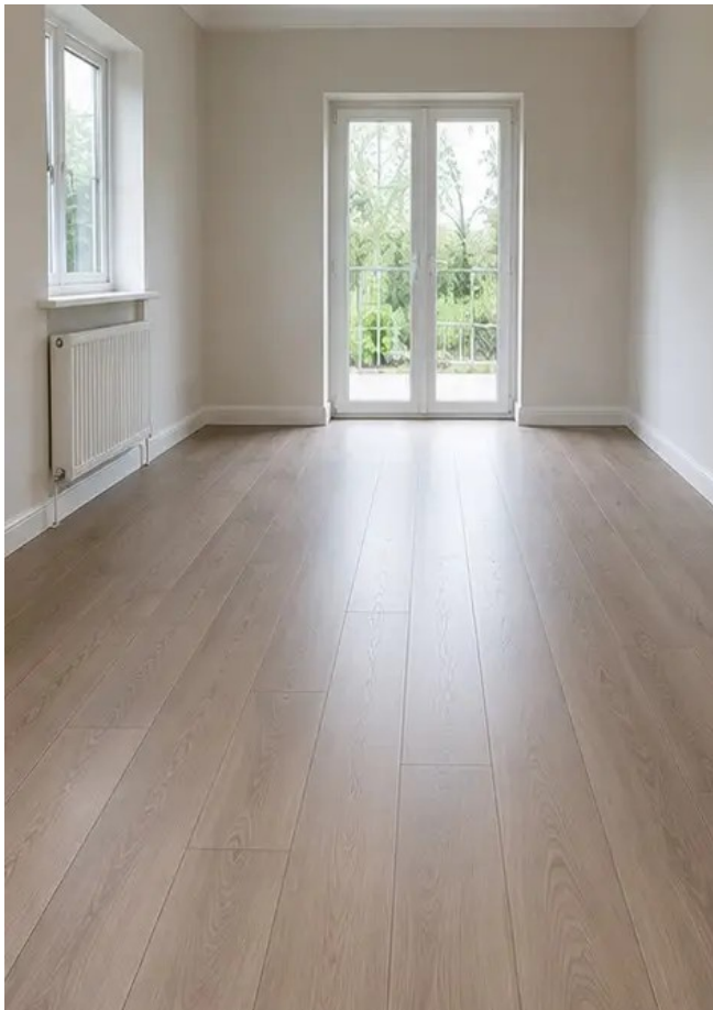
Photo n°6 État du revêtement de sol après remplacement
