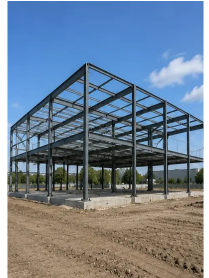
Kuva №8. Runkorakenne valmis projektiaikataulun mukaisesti
